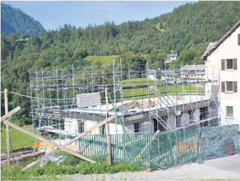
In costruzione il ristorante e alcune camere al piano superiore.
